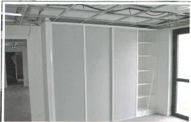
Mise en place des espaces de travail dédiés à l'UNA
