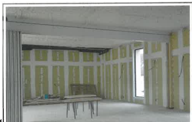
Création d'un plafond coupe-feu dans la salle des fêtes pour l'aménagement des étages, retrait du rideau et de la poutre pour assurer un système de ventilation optimal
